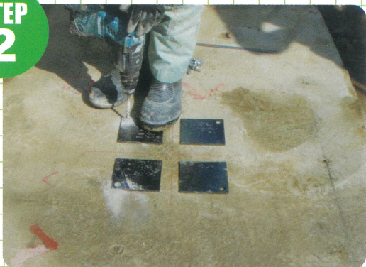
固定板取付作業
