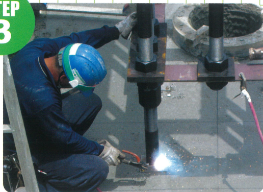
溶接により固定
